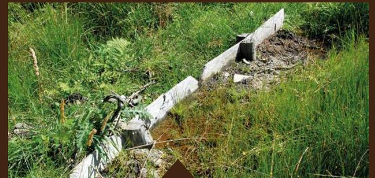
Fossé de drainage comblé pour freiner les écoulements au sein d'une tourbière
